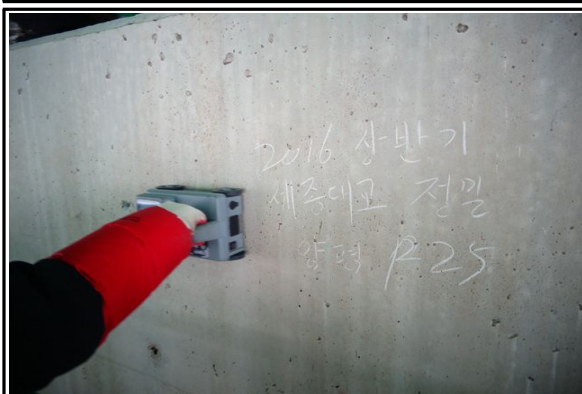
피복두께 측정 (교각)
