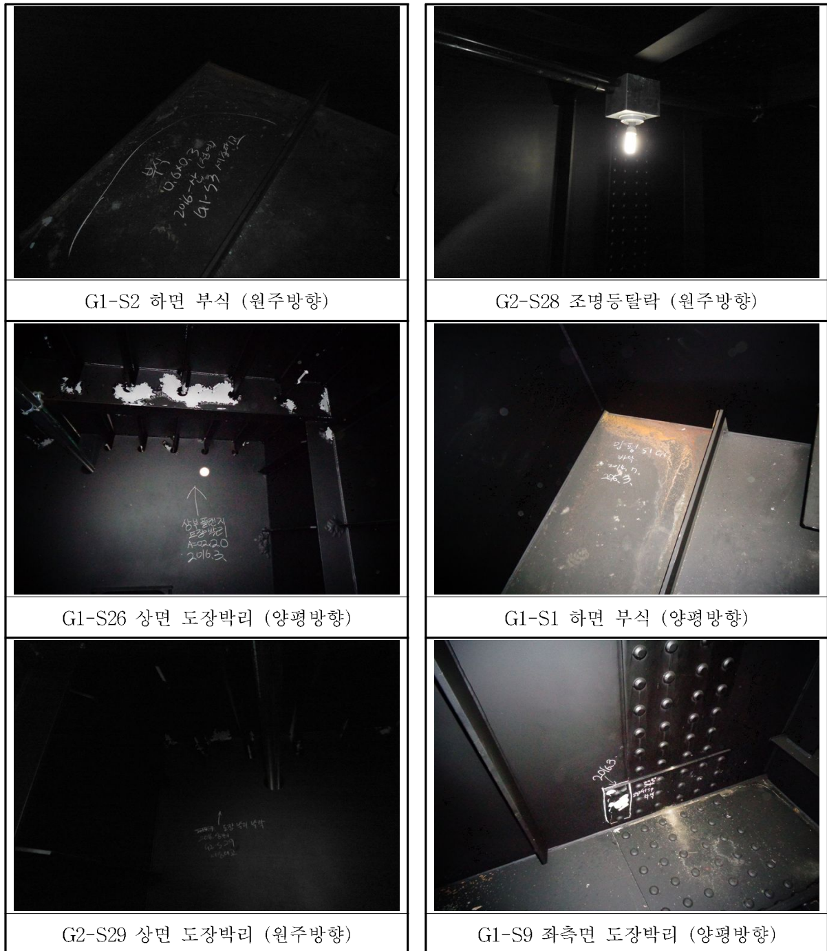
【그림 3.11】 거더내부 손상 현황
